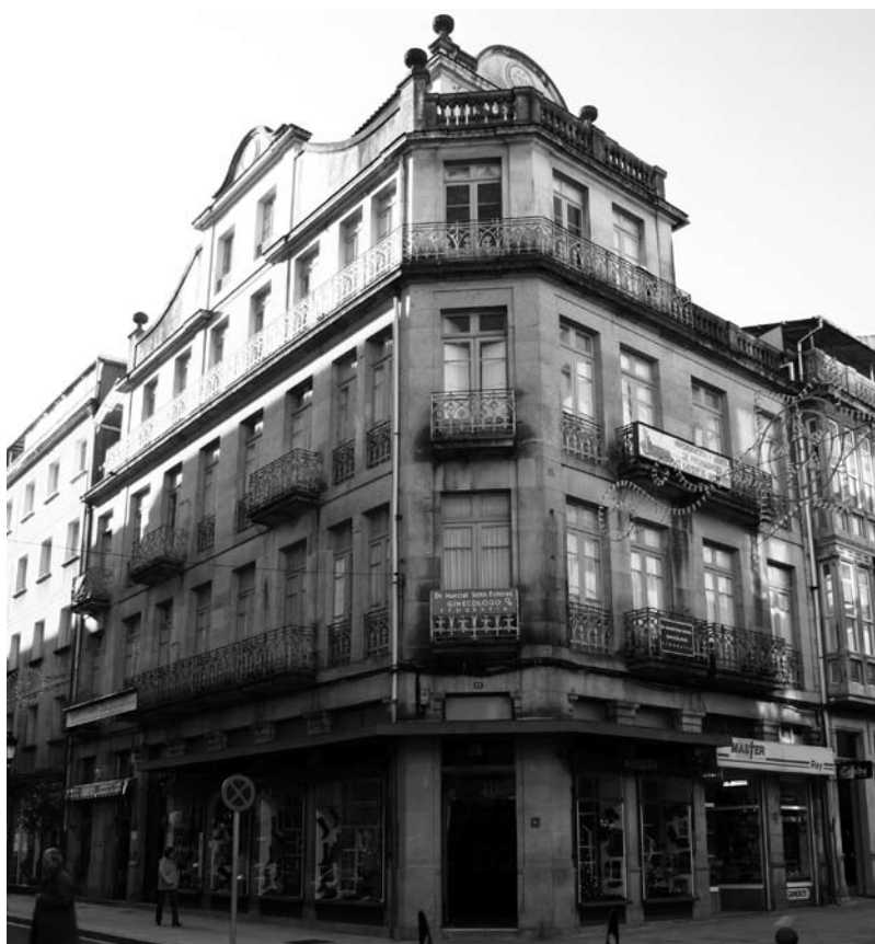
Vista xeral do edificio.
