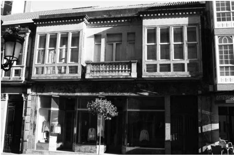
Estado da casa em 2008.
